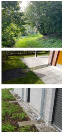
Beispiele für eine naturnahe Regenwasserbewirtschaftung: (v. o. n. u.: Muldenversickerung, Entwässerungsrinnen zur diffusen Versickerung, Versickerungsfähiges Pflaster)
