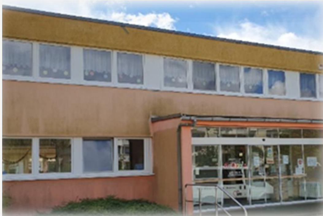
Vor dem Umbau
