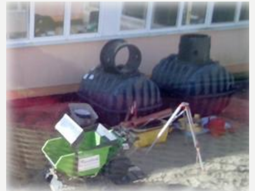
Einbau Zisterne im Frei-Luft-Raum
