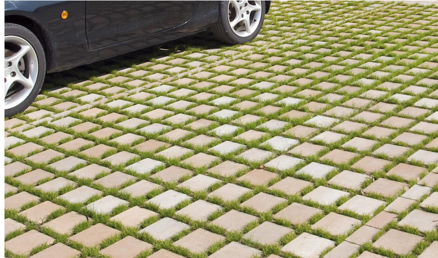
Pflasterung mit großem Fugenanteil
